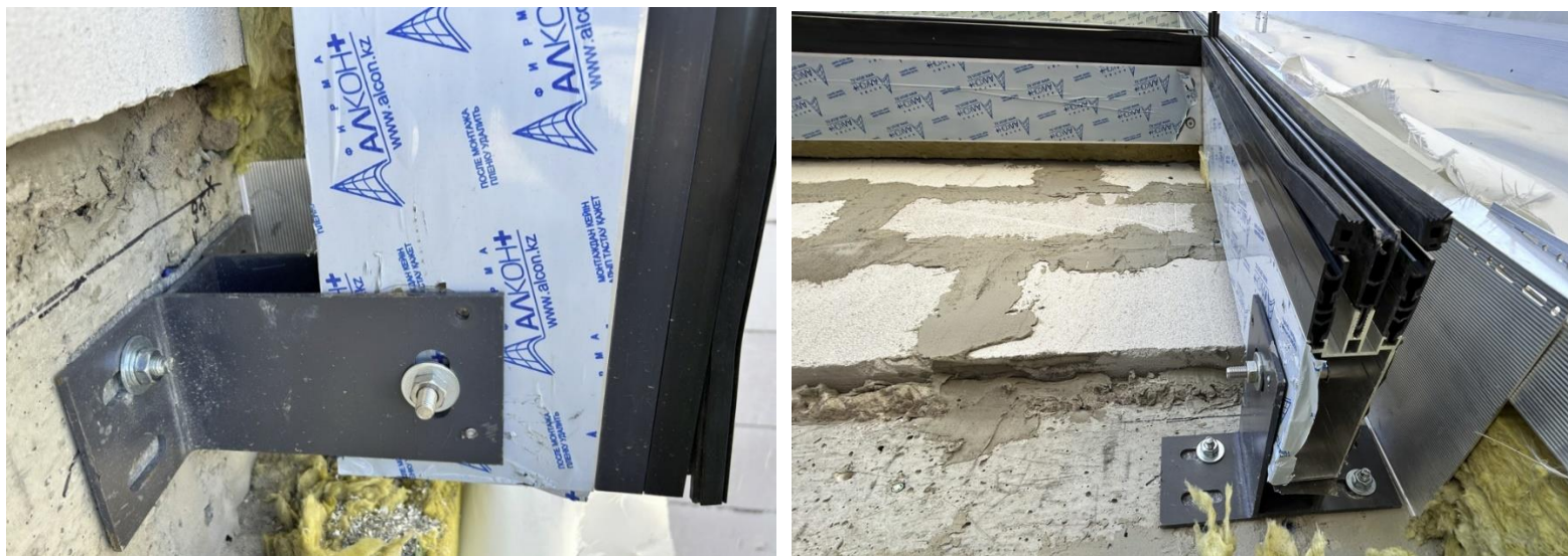
Сурет 1.6 – Жабын плиталары бойынша монтаждalған кронштейндер
