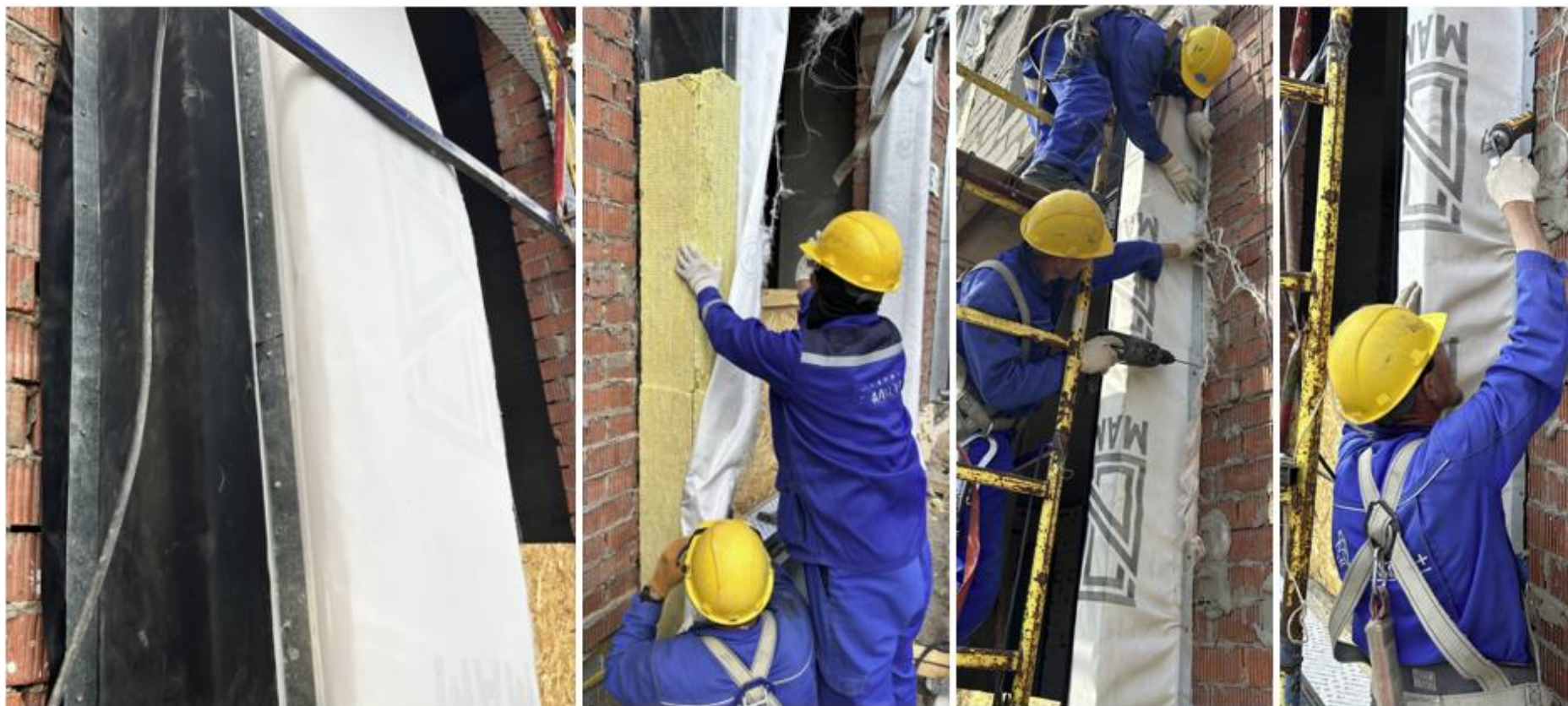
Сурет 1.11 – Витраж қаңқасы ойығын герметизациялау
