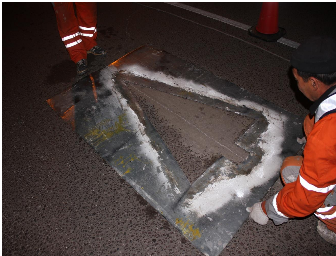
4-сурет – Таңбаны контурлау үшін трафаретті орналастыру
