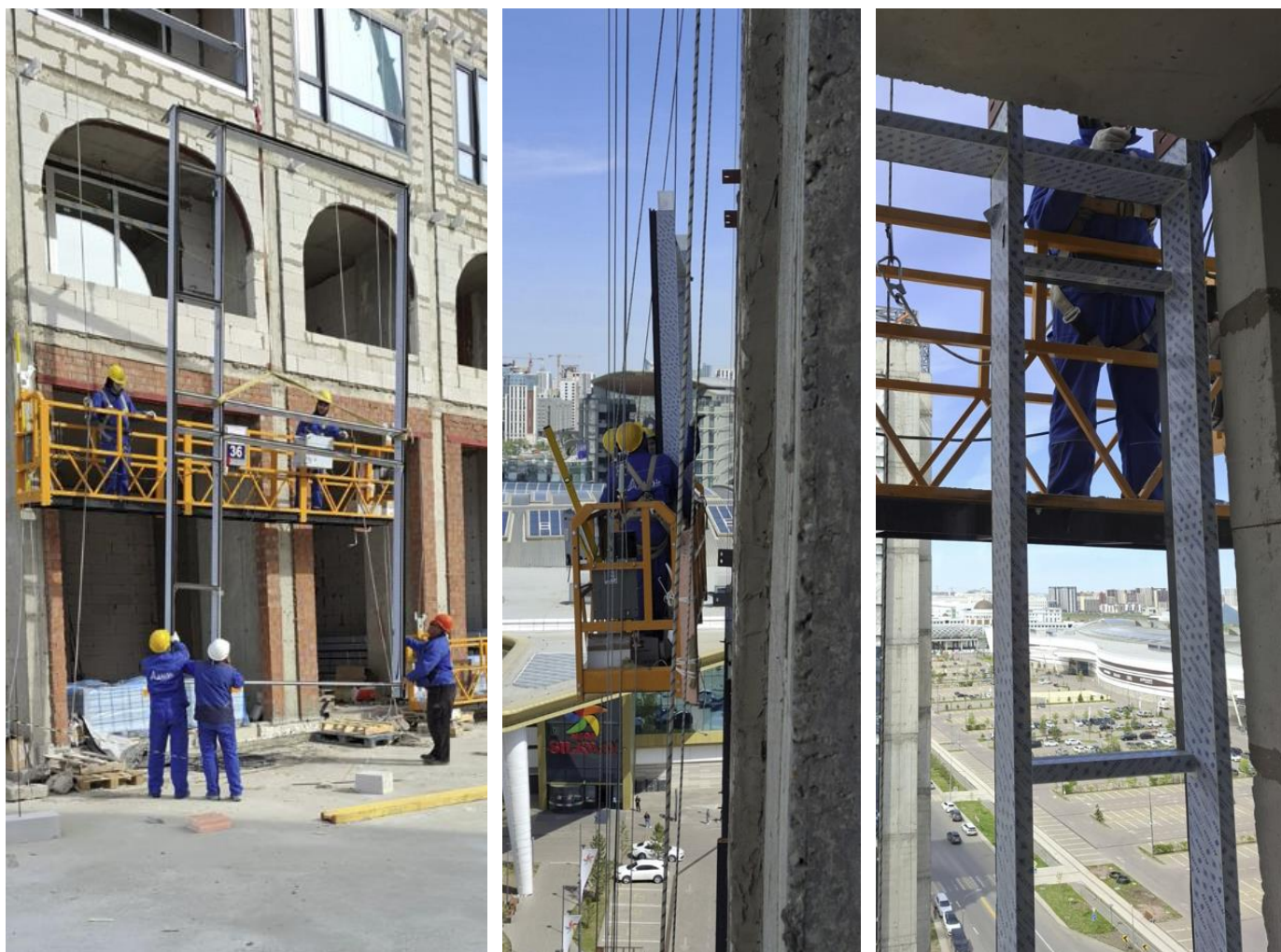
Сурет 1.8 – Витраж қаңқасын ойықта көтеру және кронштейндерге бекіту
