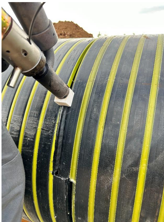
6-сурет – Құбыр түйіспелерін дәнекерлеу
